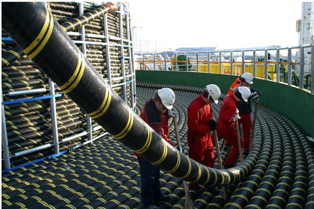
Рис. 34-2. Подготовка к укладке подводного кабеля
