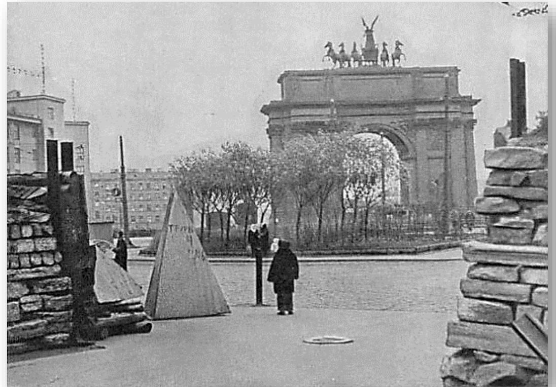
**Противотанковые надолбы** - врытые в землю рядами в определенном порядке деревянные столбы или гранитные глыбы, позднее пирамидальные бетонные или железобетонные изделия (конструкции), применяемые в качестве инженерного заграждения.
